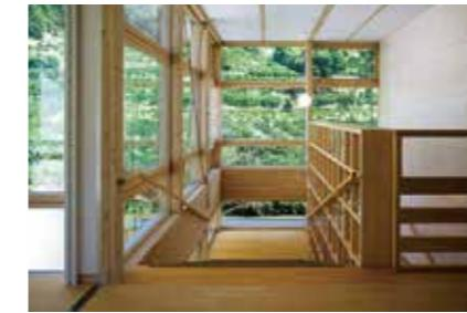
构造形式上采用了使用本地产的柳杉集成材作为承重墙，为确保水平受力在中央部位配以风车状的墙壁柱，同时为增加2楼地板的强度，采取了2段格子梁的结构形式。
